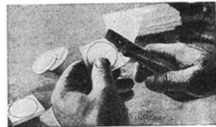
Рис. 2. Обшипывание стекла для придания ему круглой формы
