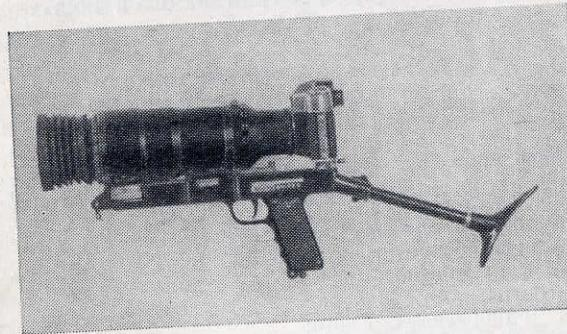
«Фотоснайпер» представляет собой фотоаппарат «Зенит-ЕС» со специальным длиннофокусным объективом «Таир-ЗФС», смонтированным на ложе с рукояткой, снабженной спусковым механизмом.
