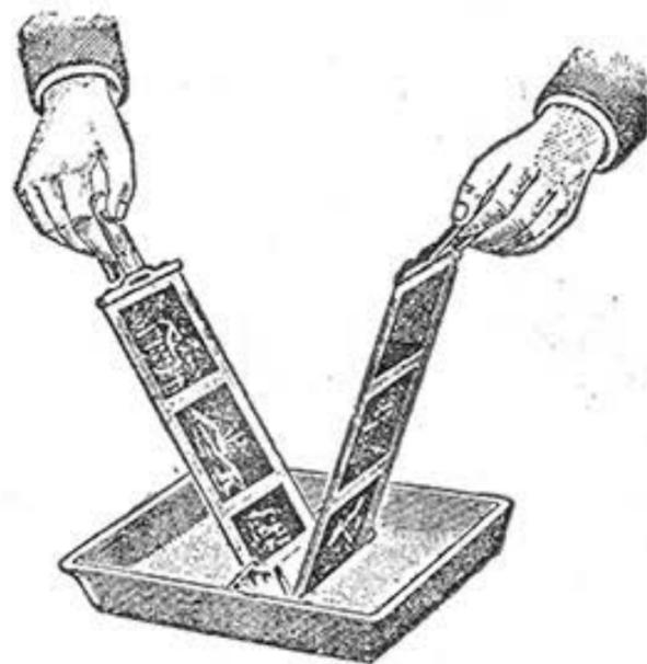
Рис. 192. Проявление неразрезанной пленки.
